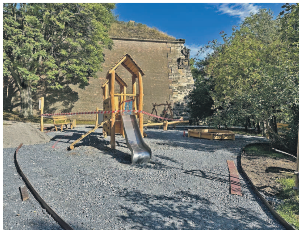
Rekonstrukce hřiště v Lumírových sadech.
